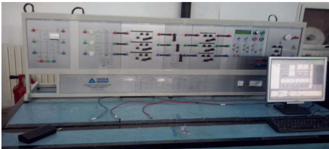
Fig. 3.2. Vedere frontală a sistemului.
